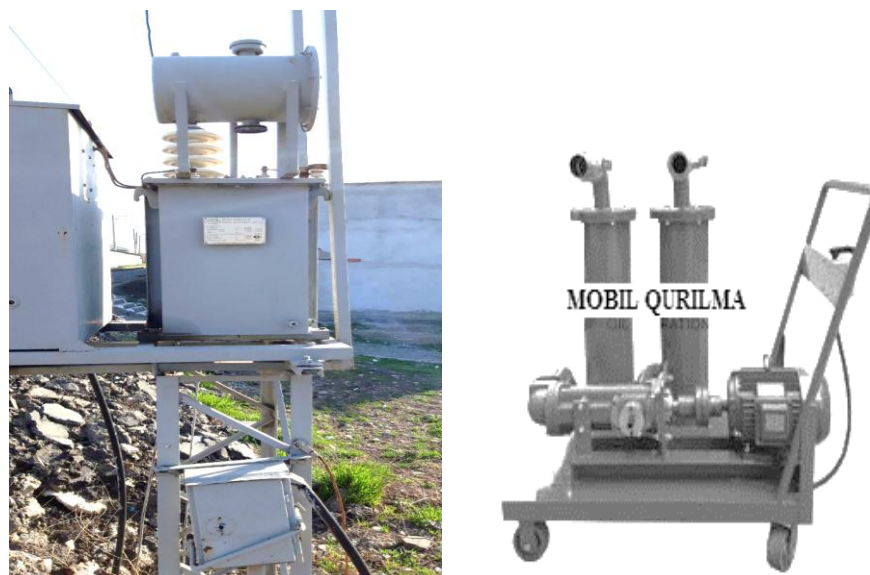
1-rasm. Eksploatatsiya joyida transformator moyini tozalash
